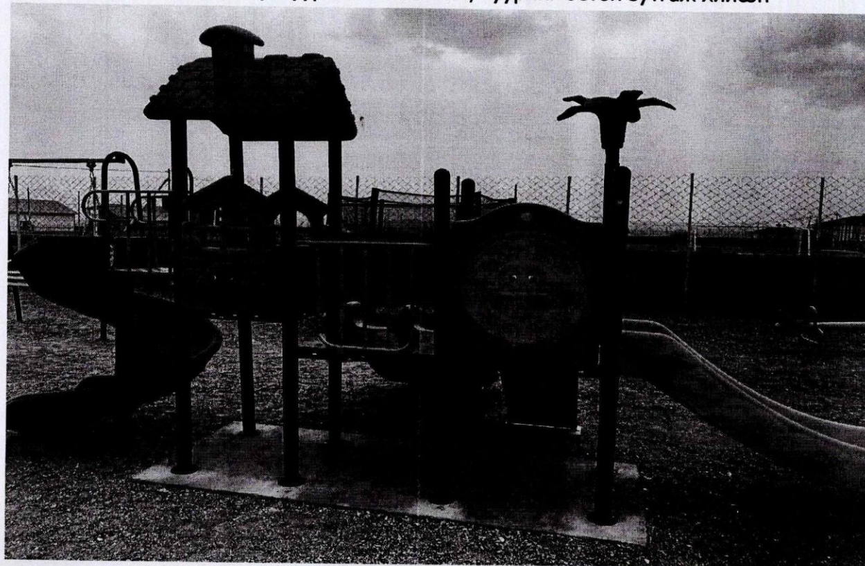
Олон үйлдэлт гулсууран тоглоом 1ш, суурийг бетон зутгаж хийсэн
